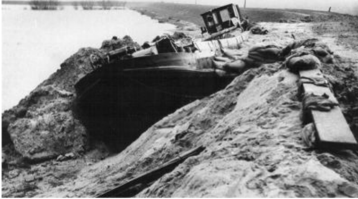
(foto: Twee Gebroeders dicht de dijk)
