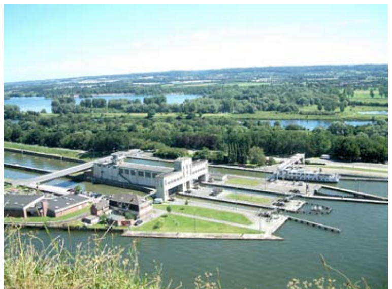
sluisencomplex bij Ternaaien
