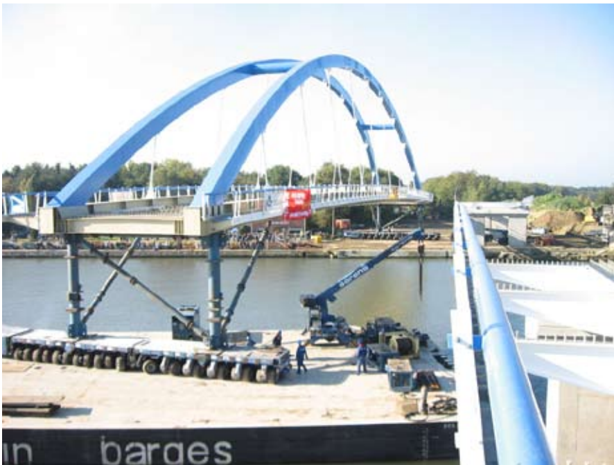
nieuwe brug Albertkanaal
